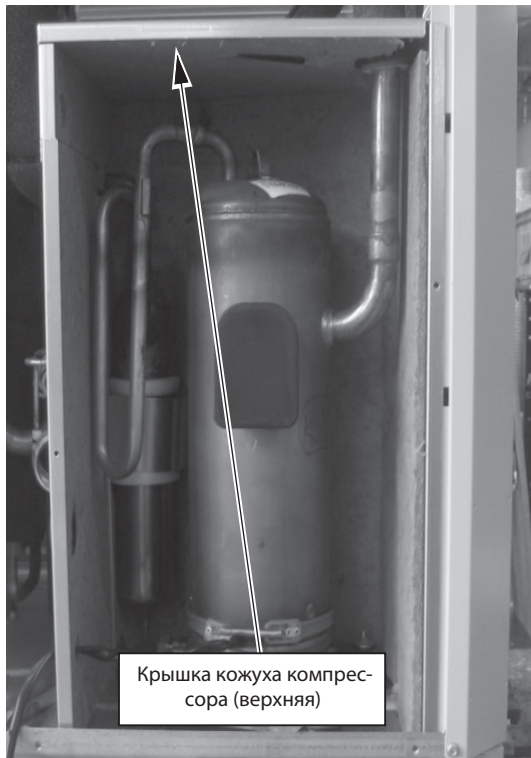
4. Снимите крышку кожуха компрессора (верхнюю).
